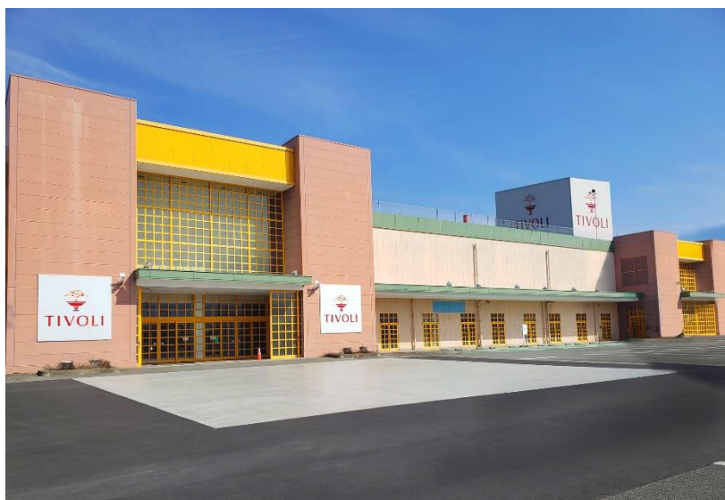
▲「山梨中央ギフトセンター」外観
